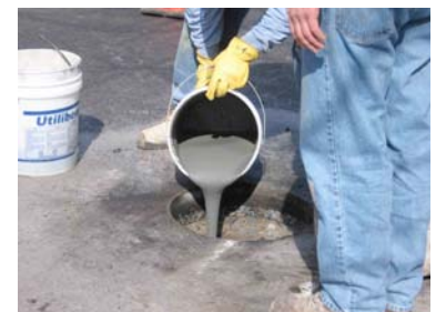
9. Pouring Utilibond in the hole
